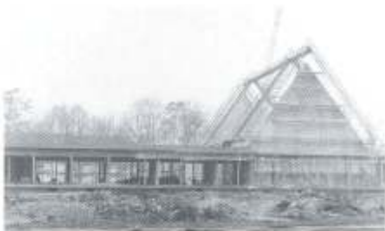
Rohbau, Ansicht von hinten
