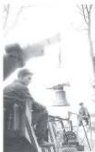
Die Glocken werden montiert
